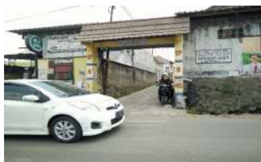
Gambar 2. Kondisi Gang Sakola, jalan masuk SLB Hanjuang Jaya
