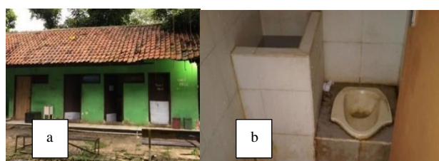
Gambar 2. Kondisi Eksisting Toilet Umum Hutan Kota Bekasi
