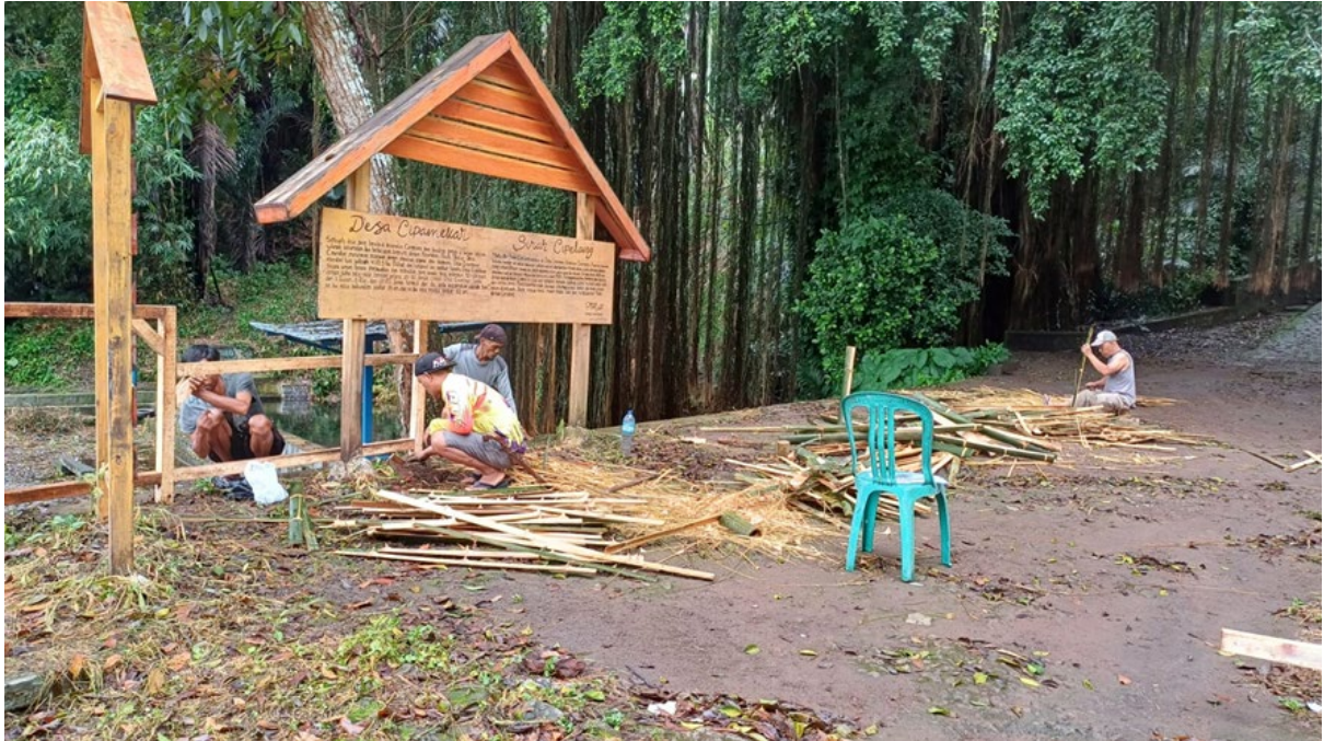
Gambar 4. Pembenahan Gapura Objek Wisata Mata Air Sirih Cipelang
